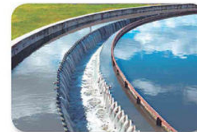
Fig. 1.47 Planta de tratamiento de aguas residuales.
